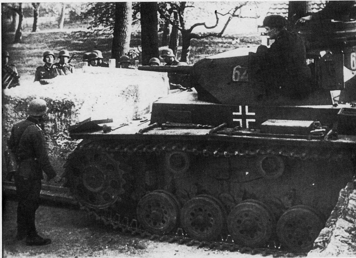
1) IN ALTO: Bella foto, decisamente d'atmosfera, di un PzKpFw III Ausf.G, riconoscibile dal particolare disegno della ruota attrice e dalla presenza del portello di uscita del personale posto anteriormente sia sulla destra che sulla sinistra del mezzo. Dalla foto non è rilevabile se la Balkenkreuz è semplicemente bianca oppure di tipo più complesso. I numeri sulla torretta sono probabilmente in giallo. Un'ultima cosa: il carro non appare ancora molto provato dalla vita di guerra.
